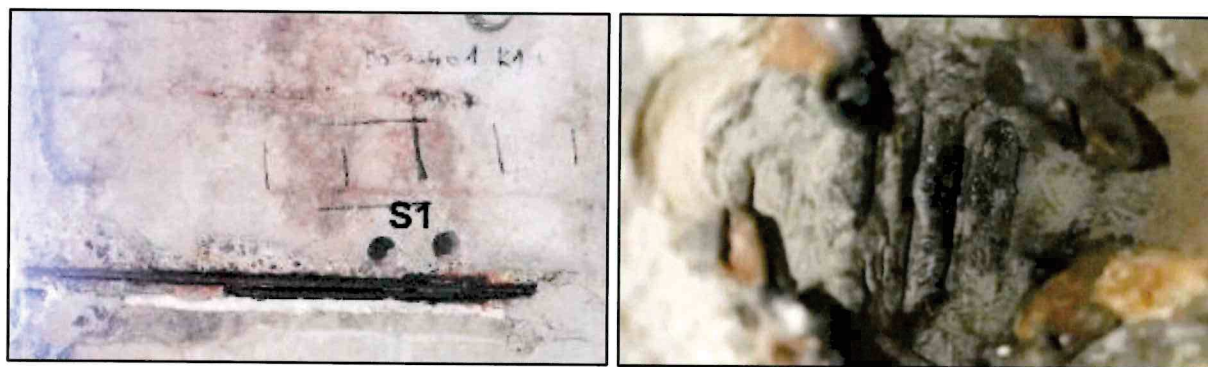
Obr. 22 Detaily vrtaných sond pro ověření injektáže předpínacích kabelů
