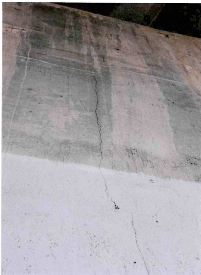
Obr. 42 Svislá trhlina v betonu dříku spodní stavby
