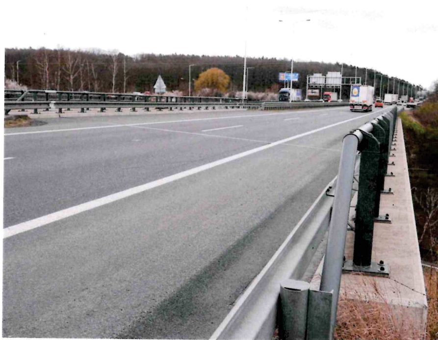
Obr. 48 Mírně vyjeté koleje ve vozovce
