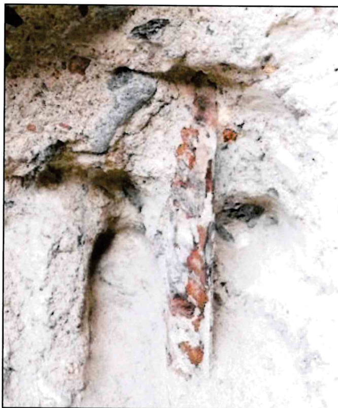
Obr. 18 Obnažená výztuž křídlo
