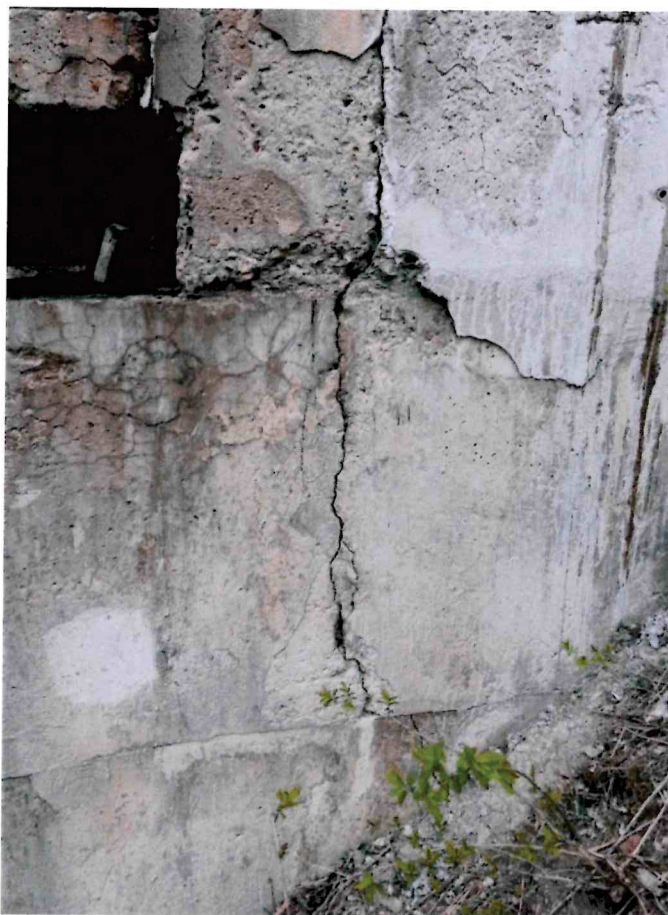
Obr. 37 Trhlina mezi závěrnou zdí a křídlem, proměnná kvalita betonu spodní stavby
