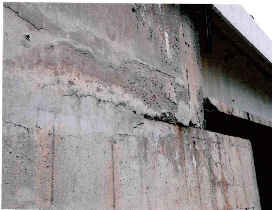
Obr. 36 Hnízda v betonu spodní stavby, zhoršená kvalita betonu
