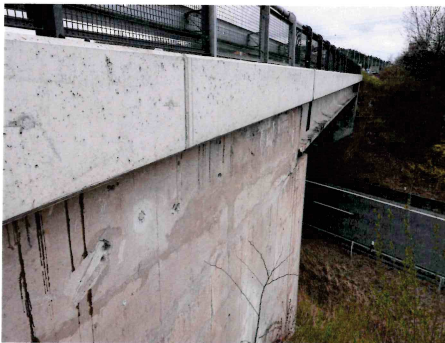
Obr. 33 Proměnná kvalita betonu spodní stavby, prokopírované pracovní spáry
