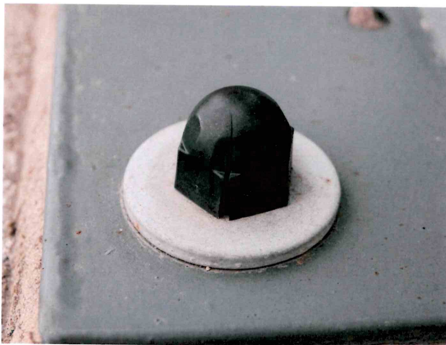
Obr. 46 Poškozená krytka kotevního šroubu zábradelních svodidel
