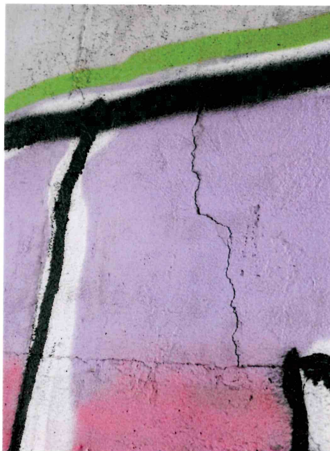
Obr. 40 Svislá trhlina v betonu spodní stavby
