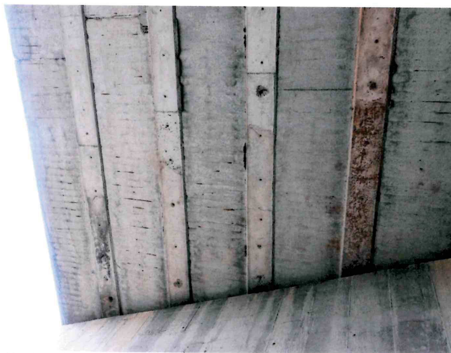
Obr. 24 Prokopírovaná betonářská výztuž nosníků IS-73, odhalená výztuž koroduje
