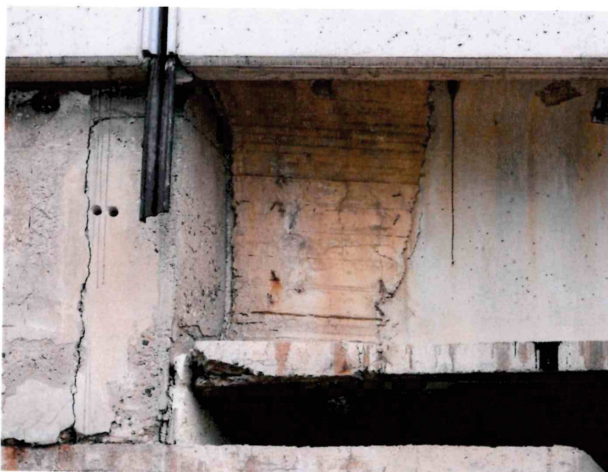
Obr. 26 Trhlina mezi křídlem a závěrnou zdí, atypická dobetonávka kotevní oblasti nosníků IS-73, drcení betonu spodní příruby
