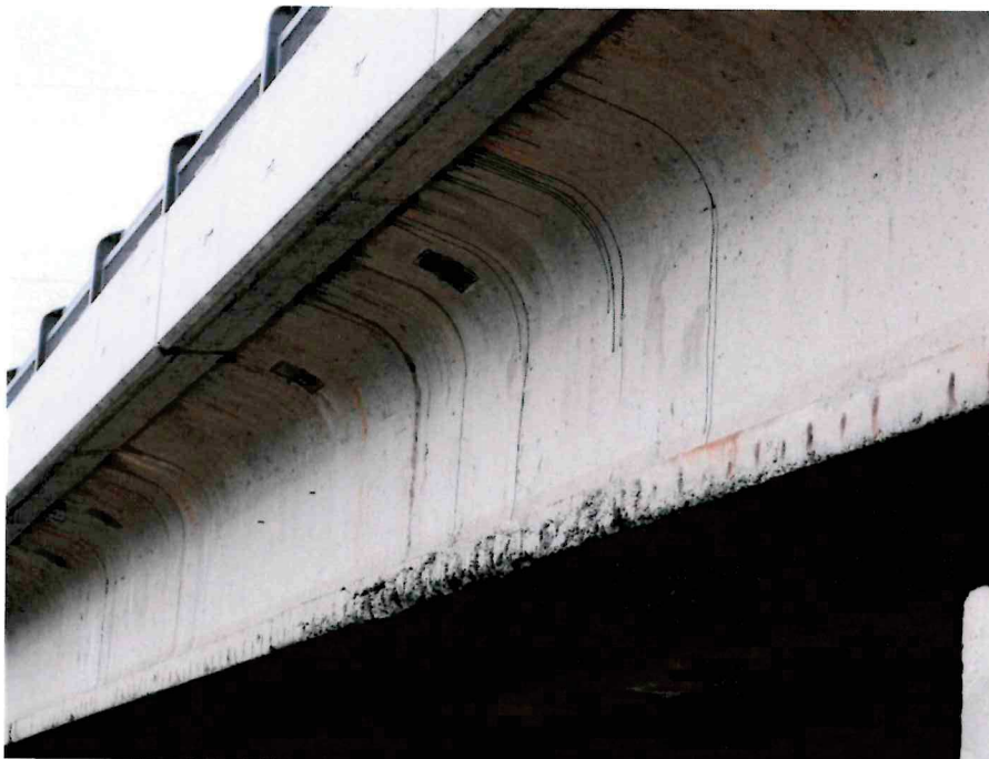
Obr. 29 Detail korodující výztuže krajního nosníku IS-73, odpadlá betonová krycí vrstva
