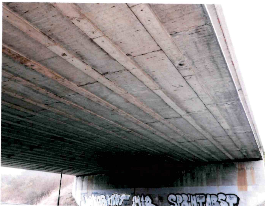
Obr. 23 Lokálně odhalená korodující příčná výztuž nosníků, na krajních nosnících stopy po zatékání
