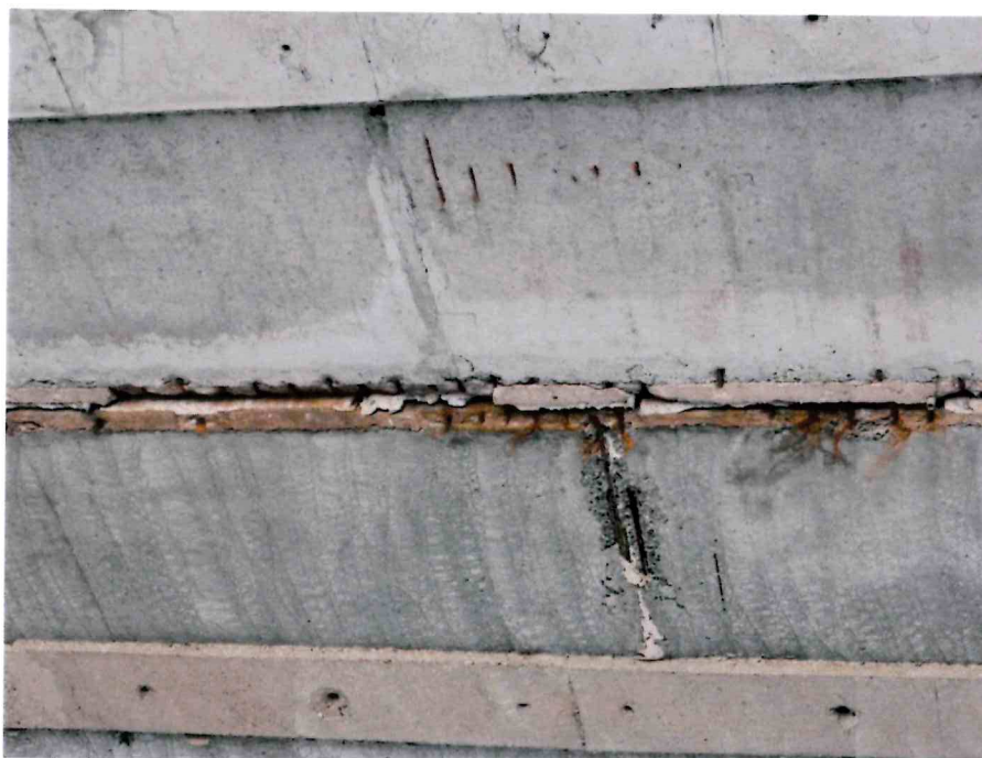
Obr. 25 Korodující odhalená betonářská výztuž
