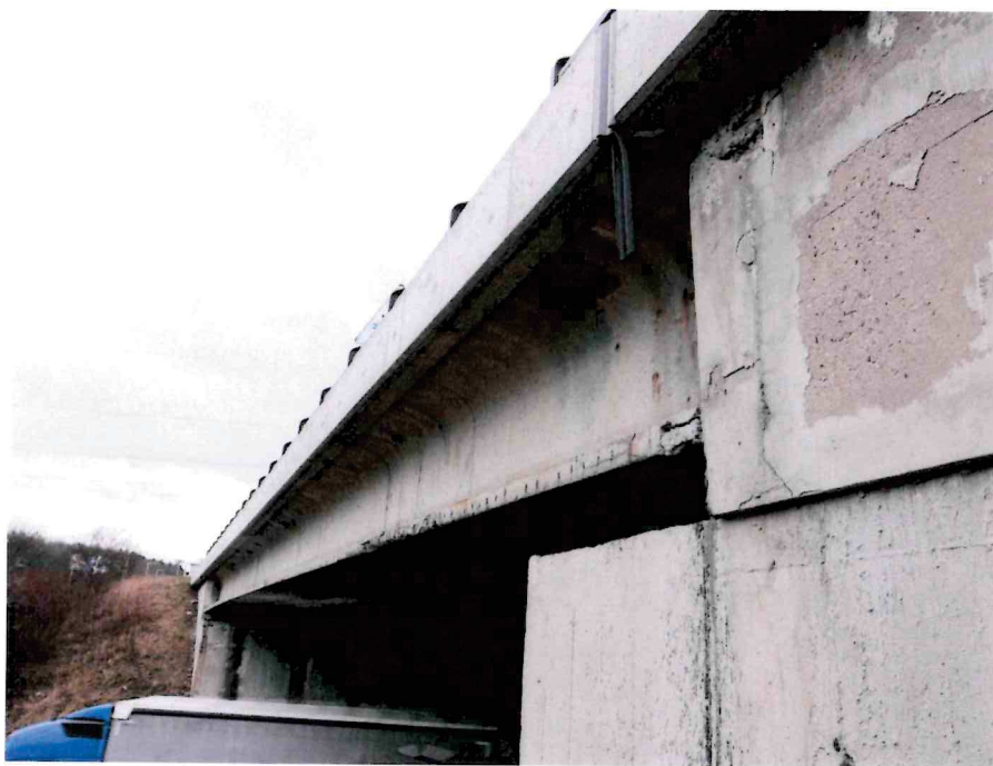
Obr. 28 Korodující odhalená výztuž krajního nosníku IS-73
