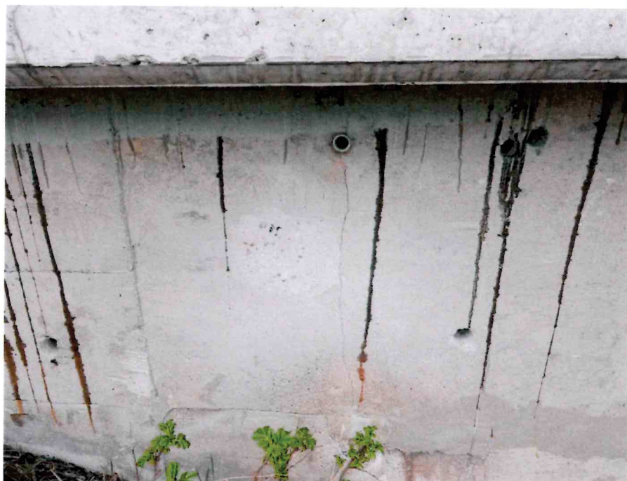
Obr. 34 Svislé trhliny v betonu kolmých křídel, stopy po stékání stavebních hmot
