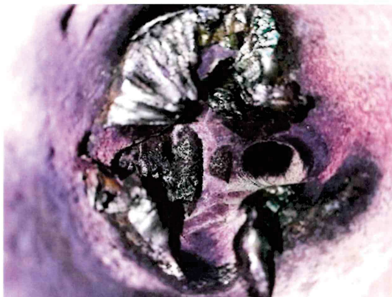
Pohled na obnaženou předpínací výztuž s použitím pH indikátoru
