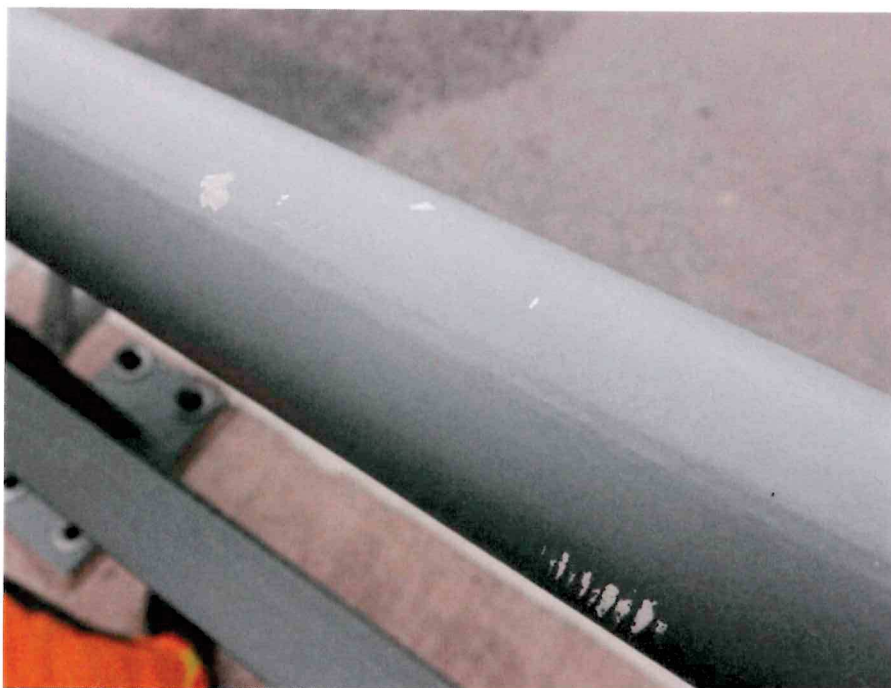
Obr. 44 Lokálně poškozen nátěr PKO zábradelních svodidel
