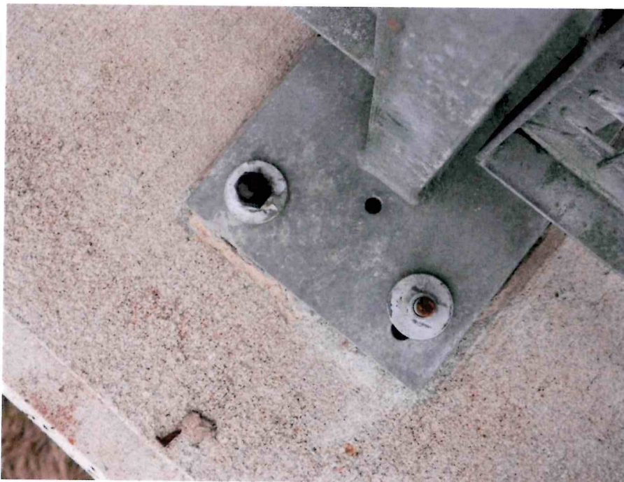
Obr. 45 Koroze šroubu kotvení zábradelních svodidel
