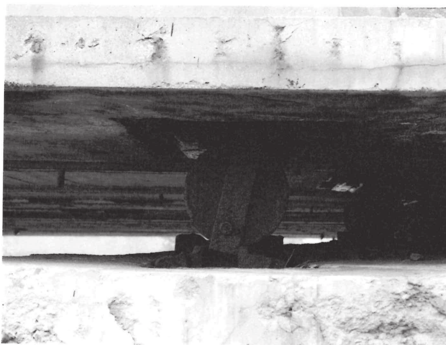
Obr. 30 Vykloněné válcové ocelové ložisko
