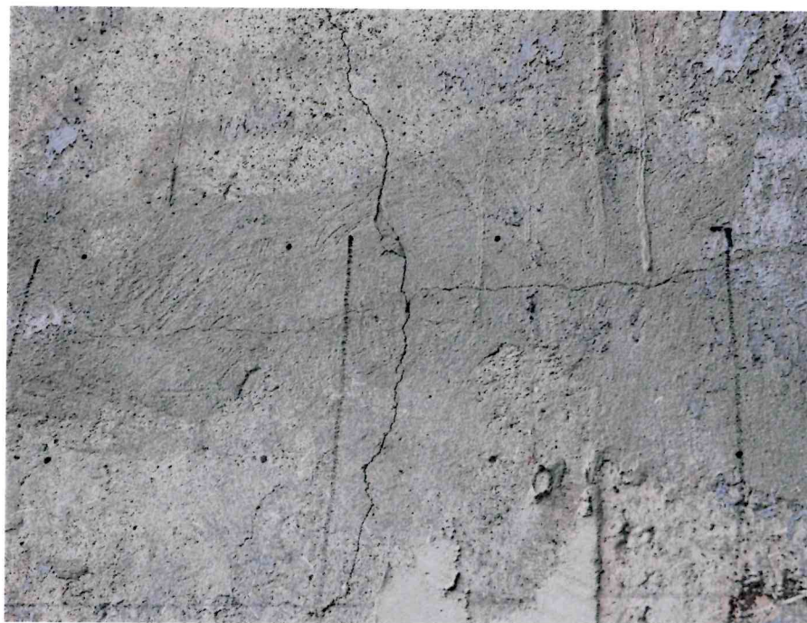
Obr. 39 Svislé a vodorovné trhliny v betonu spodní stavby
